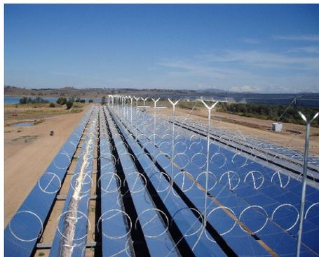
Fig. 6 – Primo piano del campo specchi di 300 metri di lunghezza e 7000 metri quadrati di superficie costruito nel 2006 a livello sperimentale dalla Ausra (Fotografia cortesia di Ausra)
