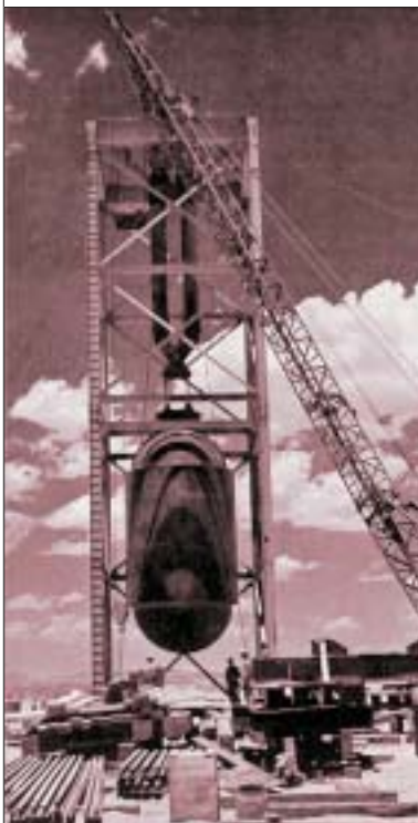
Figure 3 e 4: Le fasi di costruzione della torre di test della prima esplosione nucleare della storia dell'umanità, avvenuta il 16 luglio del 1945 ad Alamogordo (New Mexico) nel deserto "Jornada del Muerto". Il test fu chiamato Trinity e vide la partecipazione attiva di Farrington Daniels.
