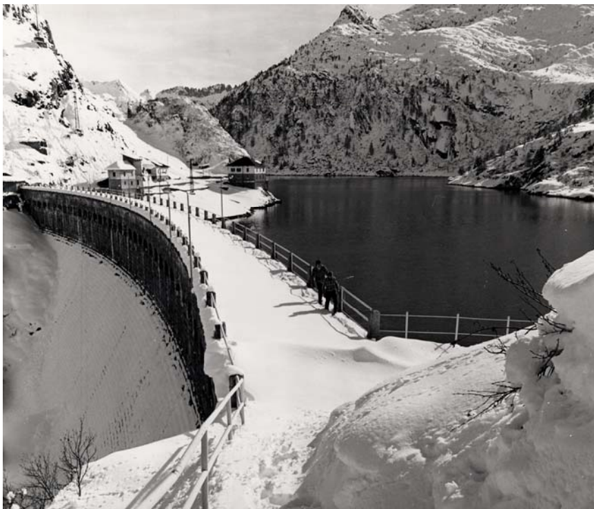
La diga del Lago d'Avio
