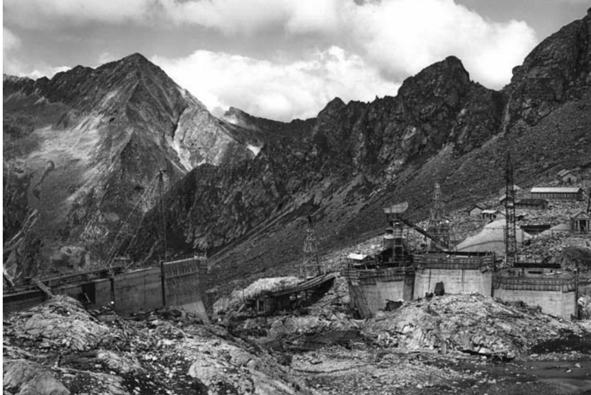
La diga del Venerocolo in costruzione. 1958
