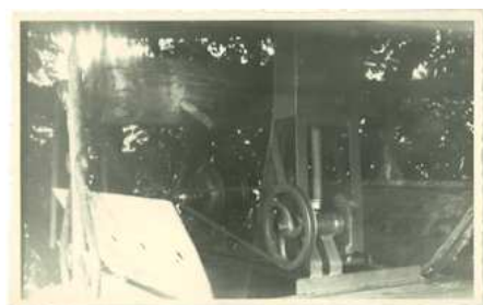
Fig. 13 - Sulla destra in alto si vede il verricello in legno con la corda per tirare l'acqua su dal pozzo dei Gasperini presso la casa di Moiana. Al centro i meccanismi della pompa Larion montata sul pozzo. (fotografia circa 1947)
