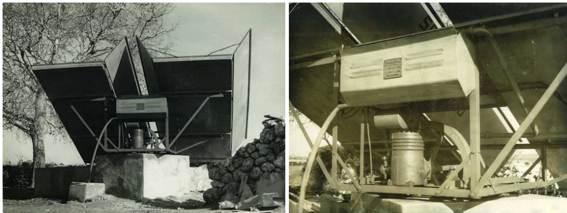
Fig. 16 - Due viste della pompa SOMOR installata nell'azienda agricola degli Olmeo vicino a Sassari nella prima metà degli anni cinquanta (Fotografie cortesia di Luisella Grassi).
