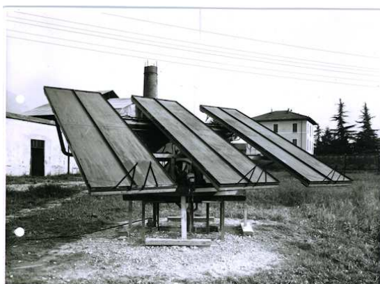
Fig. 20 - Un'immagine della pompa SOMOR nel piazzale della Metalgraph di Lecco. (Fotografia per cortesia di Luisella Grassi, anno circa 1955)
