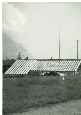
Fig. 23 - Primi piani di campi di concentratori parabolici lineari per l'alimentazione delle pompe SOMOR nel piazzale della Metalgraph di Lecco (Fotografia cortesia di Luisella Grassi, anno circa 1958).
