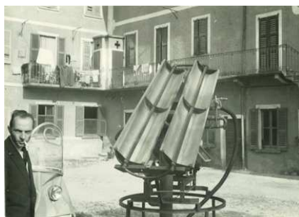
Fig. 22 - Un primo piano del prototipo di concentratore parabolico costruito da Daniele Gasperini in un'officina vicino la sua abitazione di Galbiate (Fotografia cortesia di Luisella Grassi, circa 1957)
