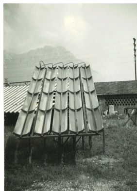
Fig. 23 - Primi piani di campi di concentratori parabolici lineari per l'alimentazione delle pompe SOMOR nel piazzale della Metalgraph di Lecco (Fotografia cortesia di Luisella Grassi, anno circa 1958).
