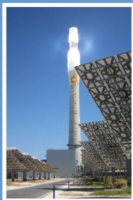
Impianto Gemasolar con sali fusi funzionante anche di notte, Siviglia, Spagna, luglio 2011.
