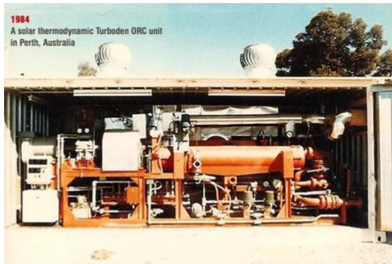
Fig. 5 – Un’immagine del motore solare ORC installato a Perth (Australia) nel 1984. Potenza elettrica 35 kW (dal ref. [5])
