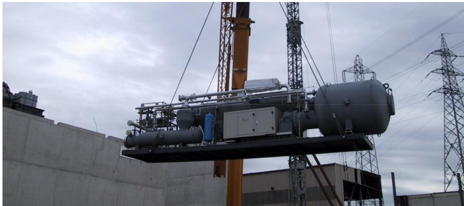
Fig. 5 – Un modulo ORC pronto per l’installazione ( http://www.turboden.eu )
