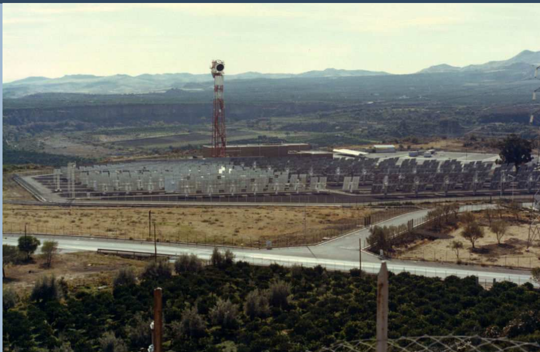
EURELIOS: primo impianto solare a concentrazione a torre e campo specchi al mondo, da 1MWe, costruito ad Adrano (Catania) e collegato alla rete elettrica nazionale nel 1981.
