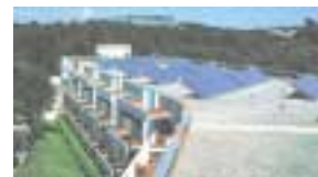
Impianto solare termico di oltre 100 m 2 su struttura alberghiera.
