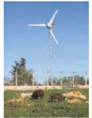
Nell'immagine una turbina eolica da 9 kW della Jonica impianti di Lizzano (TA).
