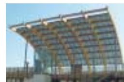
Impianto Totem FV dell'Environment Park di Torino (6,3 kWp)
