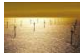
Centrale eolica offshore di Horns Rev (Danimarca) Copyright: Elsam A/S
