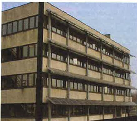
Un dato importante del progetto riguarda il previsto risparmio energetico consentito dall'ombreggiamento dei locali tramite la struttura dei "frangisole fotovoltaici" che è stimato intorno ai 50.000 kWh/anno.
