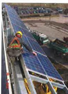
da 6 inverter (modello Master-volt SM2500-150); a ciascun inverter sono collegate quindi cinque stringhe, ognuna costituita da sei moduli fotovoltaici connessi elettricamente in serie.
