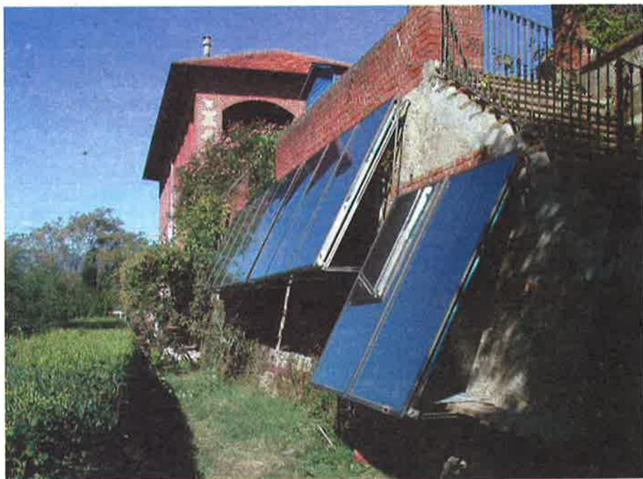
Impianto solare combinato dimostrativo a Villarbasse (TO) in una cascina ristrutturata (160 m<sup>2</sup> superficie abitata). L'impianto solare ha una superficie di collettori di 23 m<sup>2</sup> (serbatoio da 2000 litri). Il risparmio energetico atteso è del 28% su acqua calda sanitaria e riscaldamento degli ambienti (pari a 1.350 litri GPL/anno).
