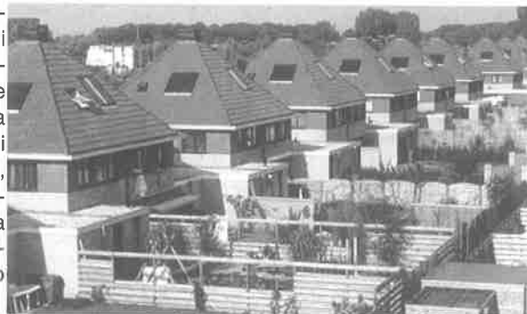
Pannelli solari installati nelle nuove abitazioni di Apeldoorn, in Olanda
