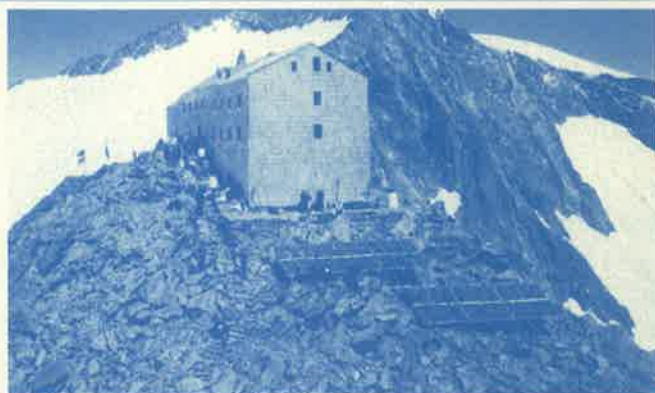
Nella foto un impianto FV per l'alimentazione di un rifugio alpino
